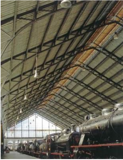
Armadura metálica roblonada de la casa Fives-Lille.
