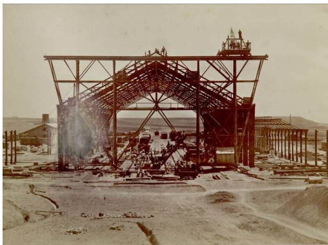
Construcción del edificio de viajeros. Fotografía de Hebert: Estado de las obras en 1º de Junio de 1879 . AHF-MFM, IG-01554.
